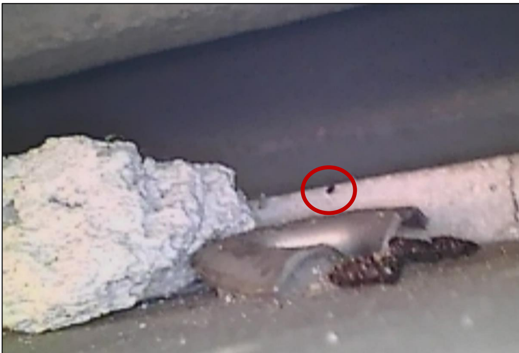
Abbildung 7: Endoskop-Ansicht von einem der fünf Kotstückchen (roter Kreis) im tieferen Hohlraum (Südostseite).
