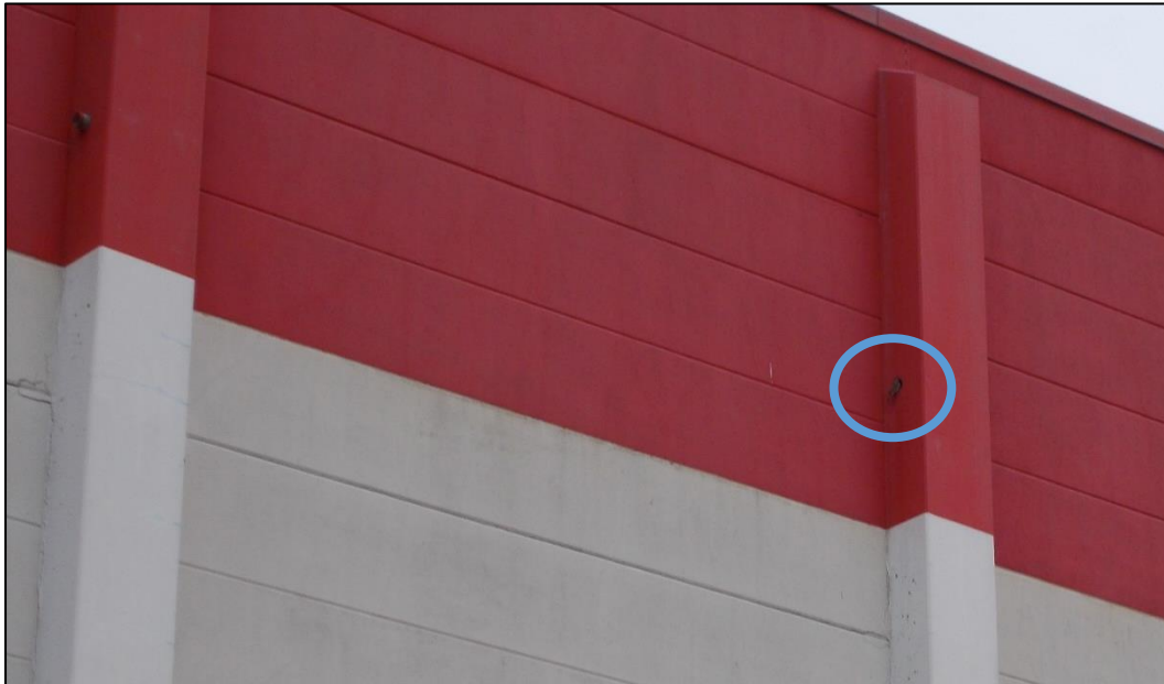
Abbildung 8: Ansicht des röhrenartigen Hohlraums am Fassadenpfeiler und der Nutzung durch Haussperlinge (blauer Kreis).
