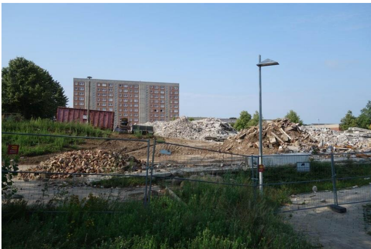
Abb.: Abriss Wohnblöcke am Berliner Platz (eigene Fotografie 08/2019)
