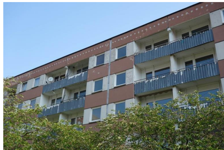
Abb.: vorhandene fünfgeschossige Wohngebäude (eigene Fotografie 08/2019)
