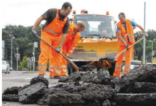
Wegen Reparaturarbeiten war eine Fahrtrichtung des Grünen Tals voll gesperrt. Foto: Reinhard Klawitter, Quelle: SVZ 05.08.2014
